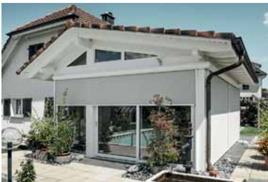
Großflächige Anlage mit Gehrungsecke
